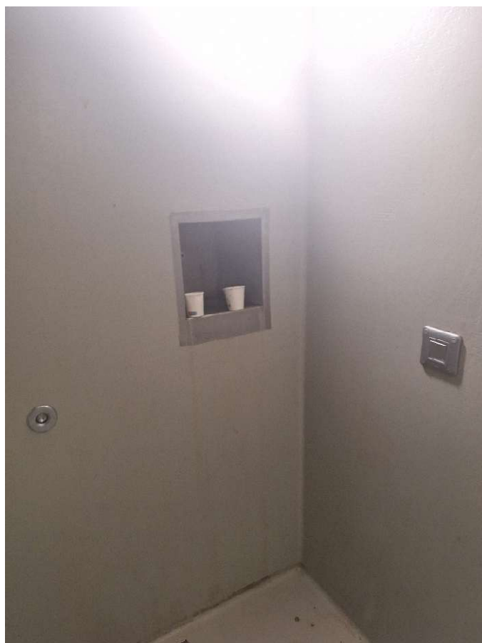
(toilettes dans les cellules individuelles)
