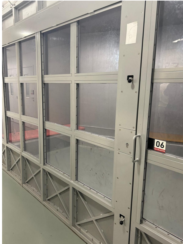
Vue extérieure de la cellule collective
