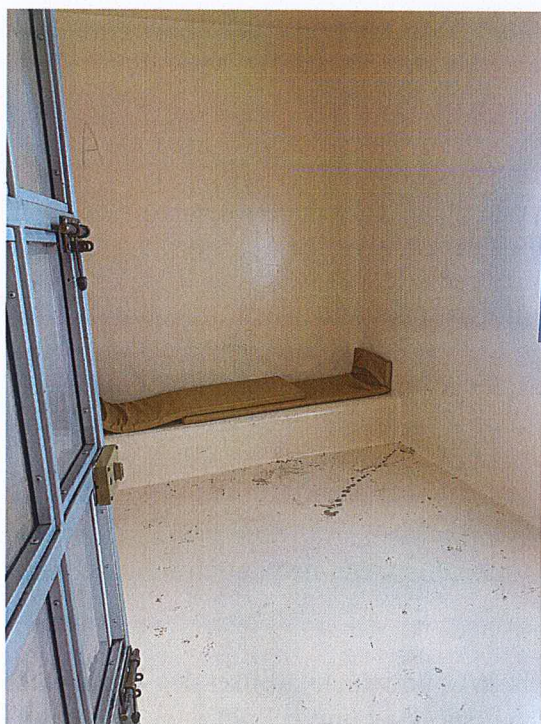
Cellule mineurs, face au poste
